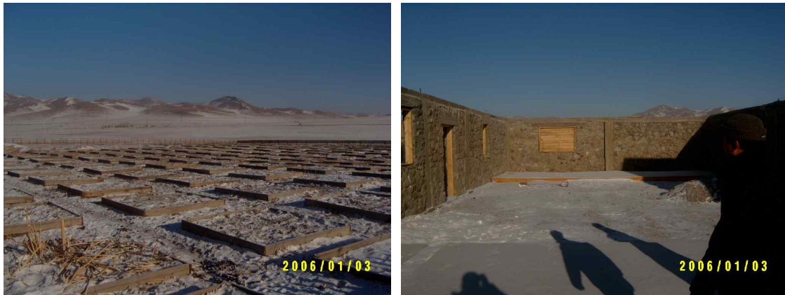
[그림 5-4] 야생식물 시험 포장과 건설 중인 교육시설
