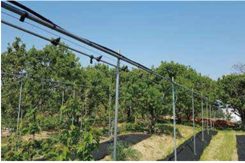
평지용 수평 회전 노즐 설치 [그림 17] 라인1 평지 회전노즐
