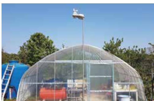
기상대는 기계실과 가까운 곳에 두어 현장여건의 실시간 자료를 수집함 [그림 3] 완성된 기계실 및 기상대
