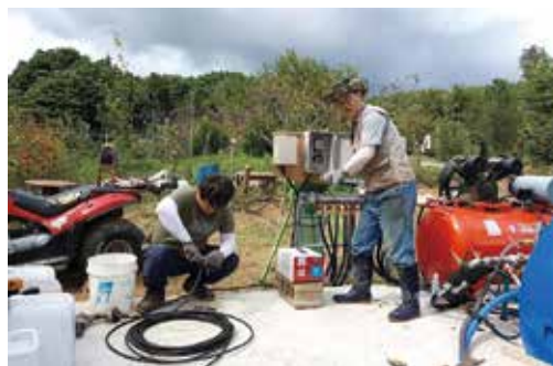
고압펌프, 공기압축기, 전기설비 및 혼합통 설치 [그림 2] 기계실 설치
