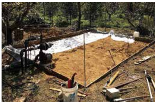
콘크리트 기초, 3×6m 관수, 전기 인입 시설 설치 [그림 1] 기반 조성
