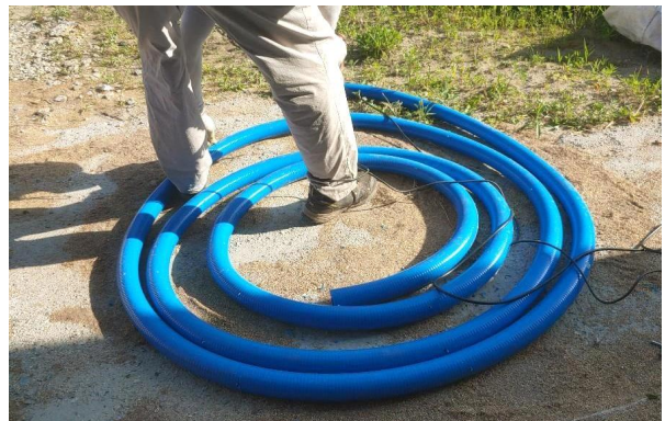
[그림 4] 공기공급용 호스 설치
