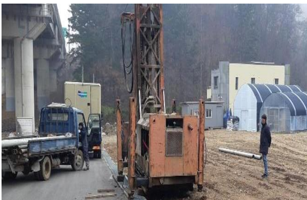
지하수 개발 전경
