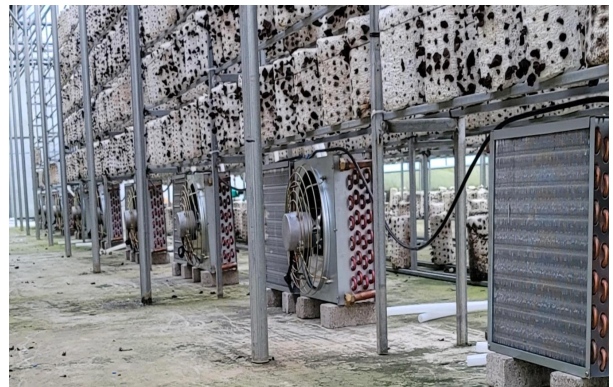
팬코일 18기 설치
